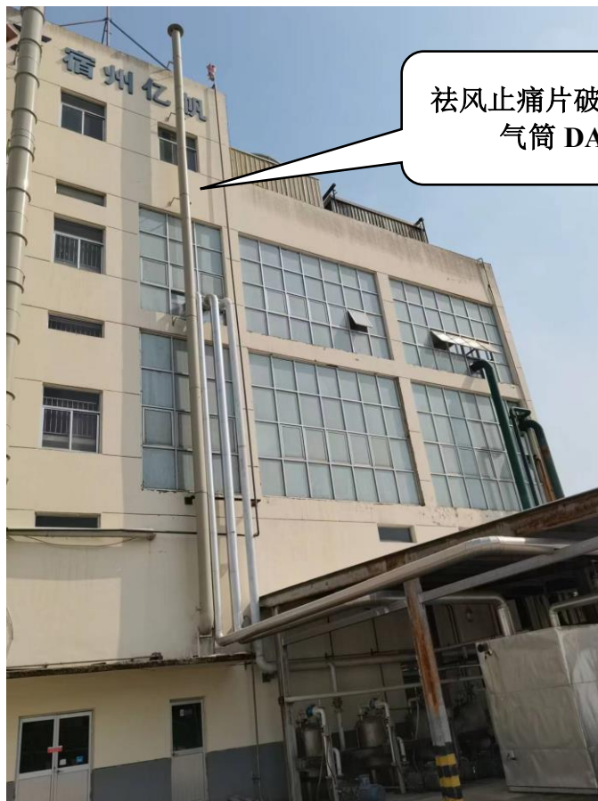
祛风止痛片破碎粉尘排气筒 (DA005)
